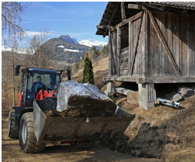
Steiler Aufstieg, enge Verhältnisse und schwere Ladung: Das Errichten von Hangsicherungsmauern gehört in das Spezialgebiet der Gebrüder Gschnitzer.
